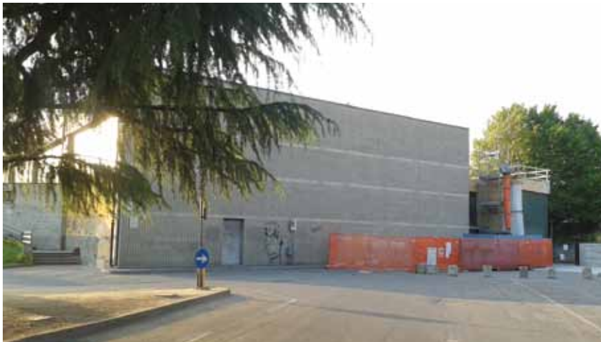
Palestra Scuola Primaria - rifacimento del manto di copertura degli spogliatoi
